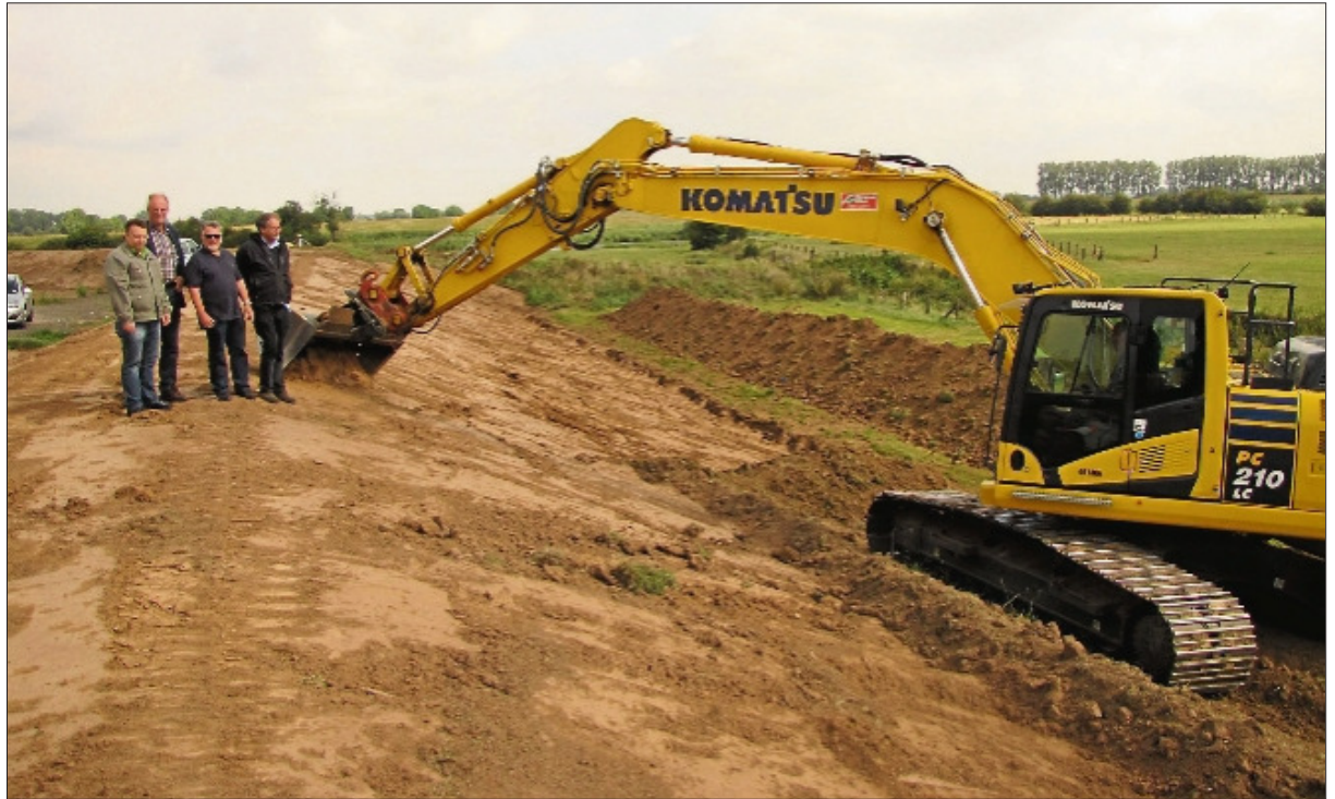
Begutachten die Deichbaumaßnahme, von links: Peter Neumann (Geschäftsführer Mittelweserverband), Gerhard Winter (Verbandsvorsteher), Werner Kochta (Niedersächsischer Landesbetrieb für Wasserwirtschaft, Küsten- und Naturschutz) und Volker Mattauch (Geschäftsleitung Mittelweser Tiefbau). ■ Foto: sp
