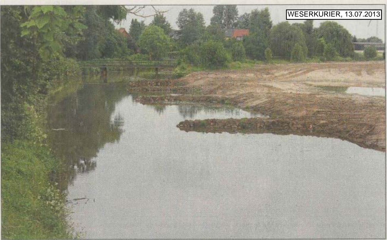
Buhnen ragen in die Eyter hinein. Sie sollen dazu beitragen, die Fließgeschwindigkeit zu erhöhen. Wo die Bagger gewühlt haben (rechts im Bild) soll sich im Laufe der Jahre eine Auenlandschaft entwickeln. • Foto: sp
