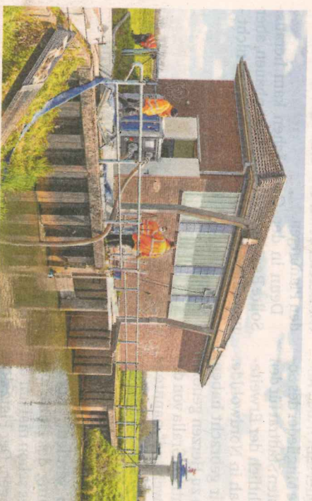
In der rechten Kammer verläuft der Sielbereich, durch den das Wasser im Normalfall im Freigefälle vom Seegraben in die Ochtum fließt.
