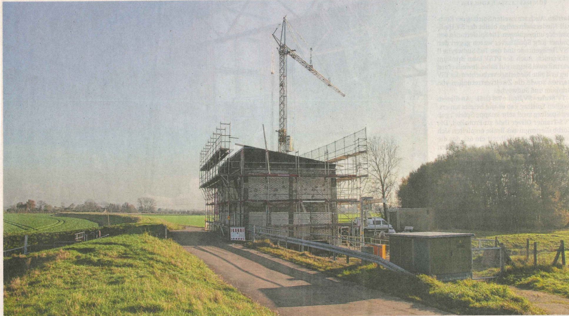
Momentan laufen die Arbeiten am Dach des Schöpfwerkes. Weitere Arbeitsschritte folgen noch.
